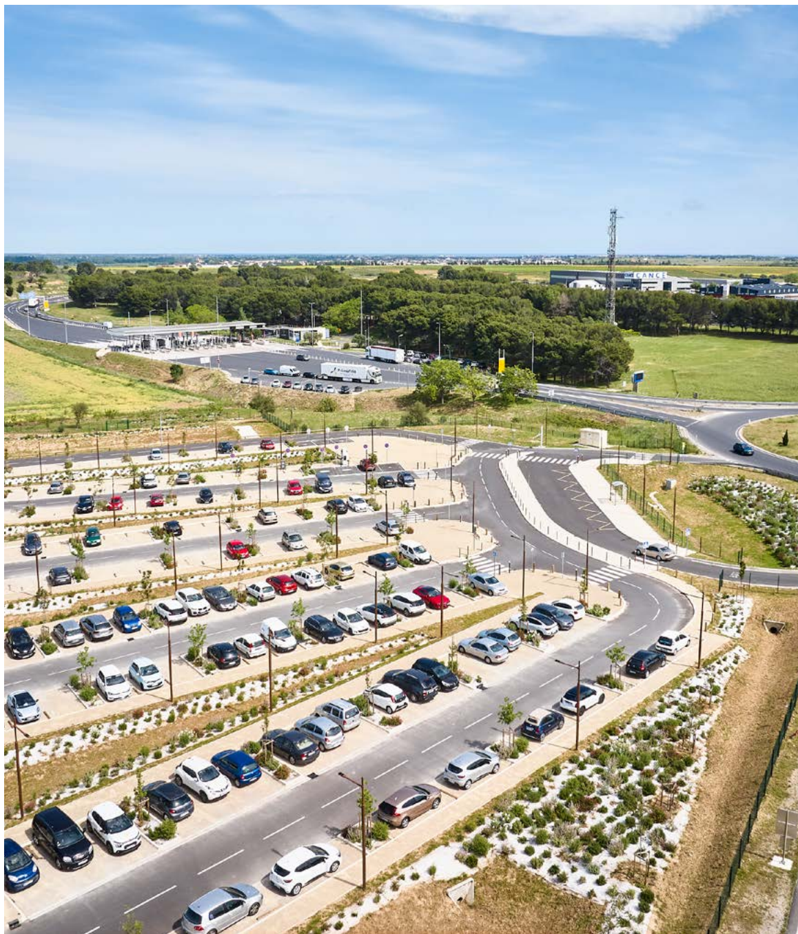
Le nouveau parking de covoiturage de Béziers ouest (Hérault), sur l'A9, doté de 165 places de stationnement gratuites.
