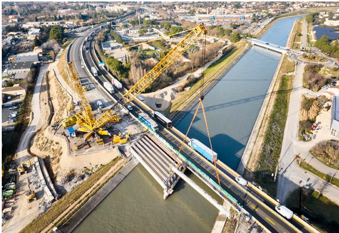
Remplacement du pont qui enjambe le canal EDF sur A54 à Salon-de Provence. Les poutres de l'ouvrage ont été déposées et concassées sur place. Elles sont recyclées à 100 % (béton et acier).
