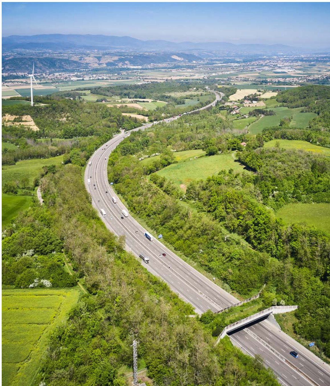
Écopont du Col du Grand Bœuf, sur l'A7, dans la vallée du Rhône.
