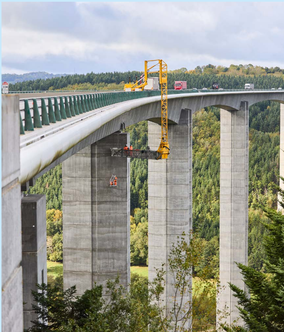
Inspection détaillée du viaduc de la Sioule (A89) réalisée dans le cadre du suivi et de la gestion du patrimoine.
