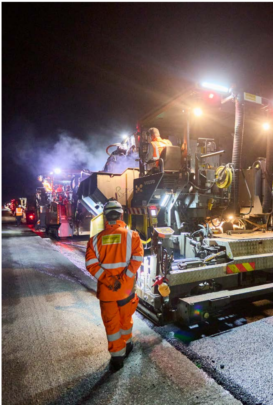
Ci-dessus et ci-contre : travaux de rénovation des chaussées entre Arzens et Carcassonne Est (A61). Sur ce chantier, 40 % des enrobés de l'ancienne chaussée dont 50 % de la couche de liaison ont été réemployés pour fabriquer la nouvelle structure.
