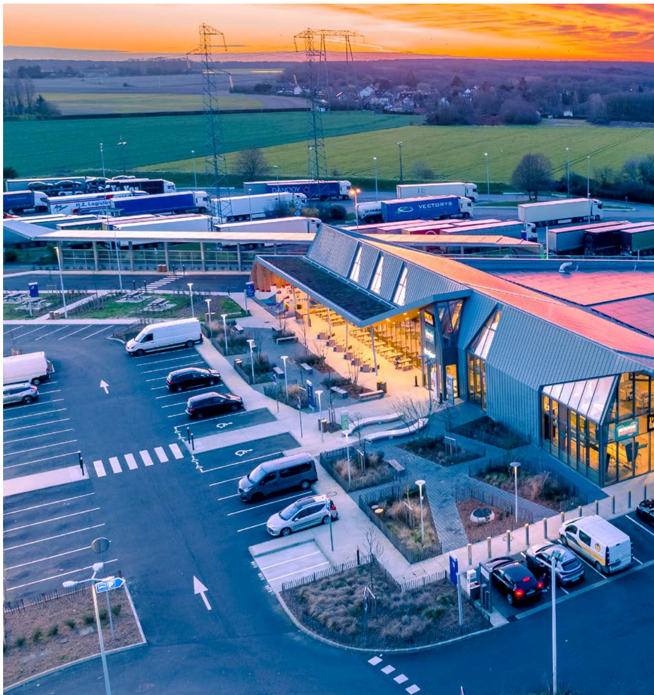
L'aire de services rénovée de Briis-sous-Forges, sur l'A10, inaugurée en avril 2024.
