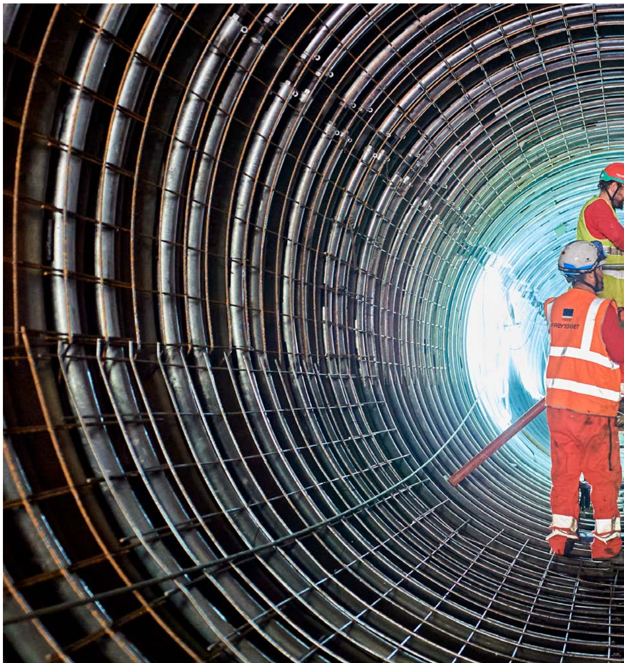
Travaux de renforcement de buses hydrauliques situées sous l'autoroute A9.
